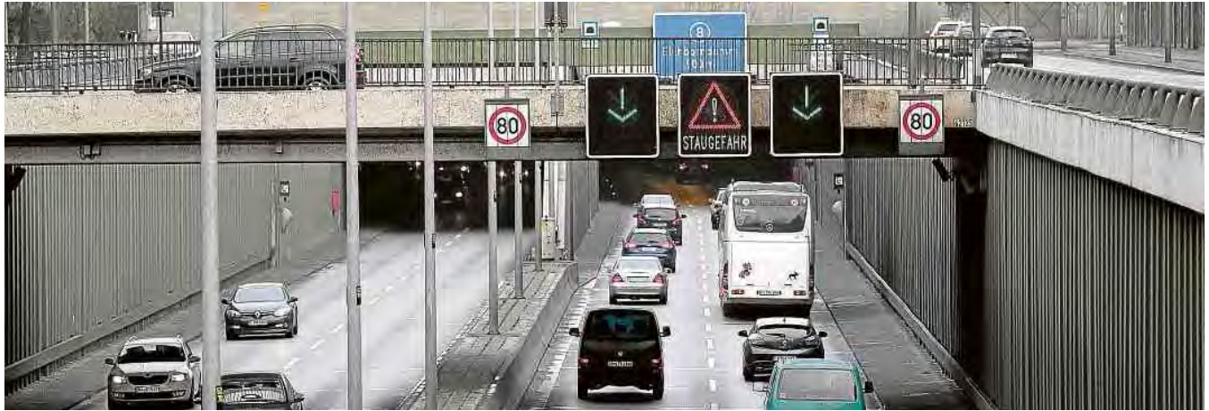
Bitte nicht drängeln: Seit 39 Jahren gibt es den Tunnel unterm Flughafen Tegel, hier die Einfahrt zu der 878 Meter langen Röhre stadteinwärts. Wenn es zu voll wird, muss die Leitzentrale reagieren – und die Zufahrten schließen.
